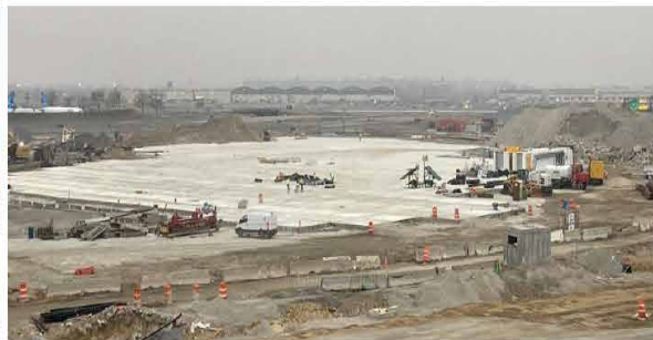
Parcel M Paving
